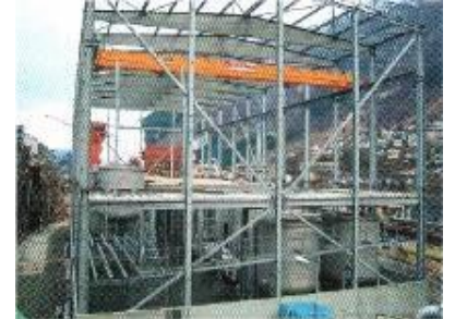
Keskipiiteräksiä teollisuusrakennuksessa.
