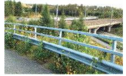
Noin 15 vuotta käytössä olleet teräsrakenteet.
