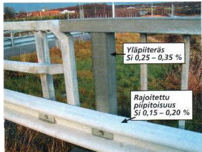
15 vuotta käytössä olleet siltarakenteet.
