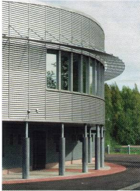
Vähäiset värierot voivat elävöittää julkisivua.
